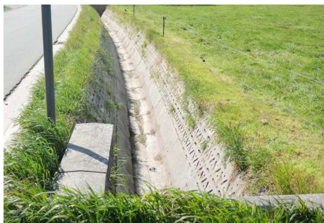
Aanleiding: Geen klimaatrobuust watersysteem Zicht op gracht langs Leegstraat die enkel gericht is voor afvoer.
