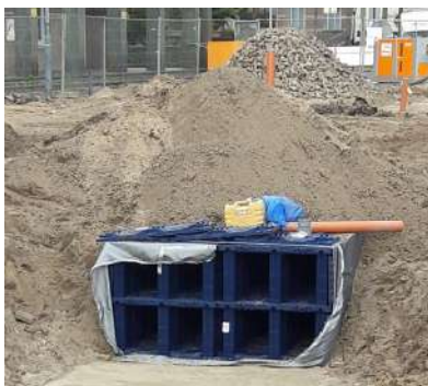
Met infiltratiekragen kun je ondergronds hemelwater opvangen en laten infiltreren als er weinig plaats is. bv. marktplaats Veghel © Domien van der Meijden
