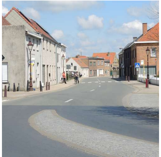
De Zevekotestraat met verharding van gevel tot gevel, met amsterdammertjes en een eiland in kassei als enige verkeersremmers, en nergens verkoelend groen of blauwe wateropvang.
