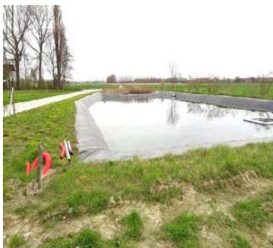
De aanleg van een waterbuffer biedt bijkomende opvangmogelijkheden van hemelwater voor de landbouw.
