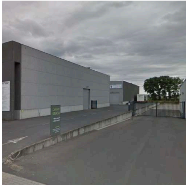
Het hemelwater van verharde oppervlakte zoals hier op de KMO zone aan de Zevkotestraat wordt afgevoerd via grachten en riolering naar de polder in plaats van lokaal te hergebruiken of te laten infiltreren.
