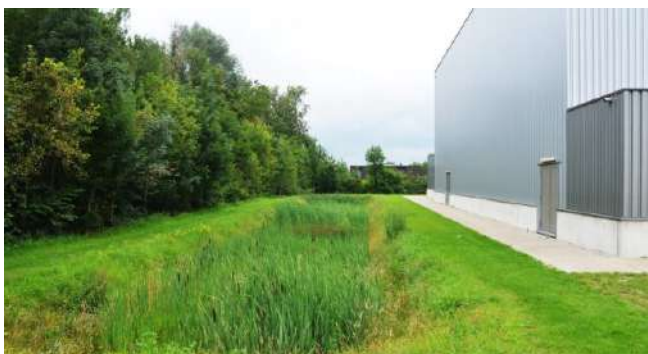
Opvang- en infiltratiebuffer voor hemelwater van grote verharde oppervlakten. bv. Herk-de-Stad, blauwgroenvlaanderen.be
