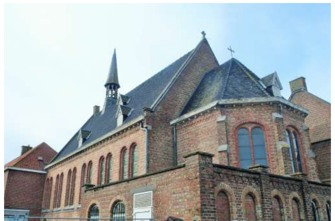
De vervallen kapel van het voormalig klooster vormt voor inwoners een deel van het historisch en typisch patrimonium van het dorp.
