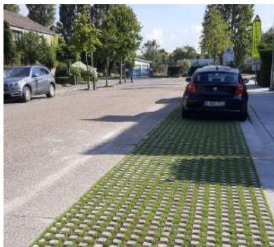
Parkeerstroken met grasbetontegels met bufferende onderfundering om het hemelwater op te vangen en de straat te vergroenen bv. Eupenlaan, Temse
