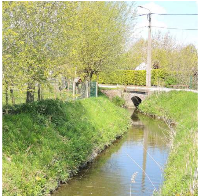
Ter hoogte van de Leffingestraat: Er wordt automatisch water afgevoerd, enkel op basis van twee richtpeilen en de bergingscapaciteit benedenvaarts.
